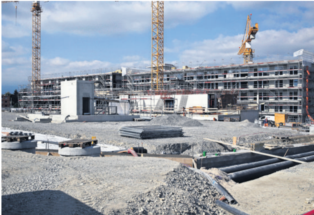
Vue sur le chantier des Vergers, l'un des plus gros projets immobiliers du canton. STEVE IUNCKER-GOMEZ
